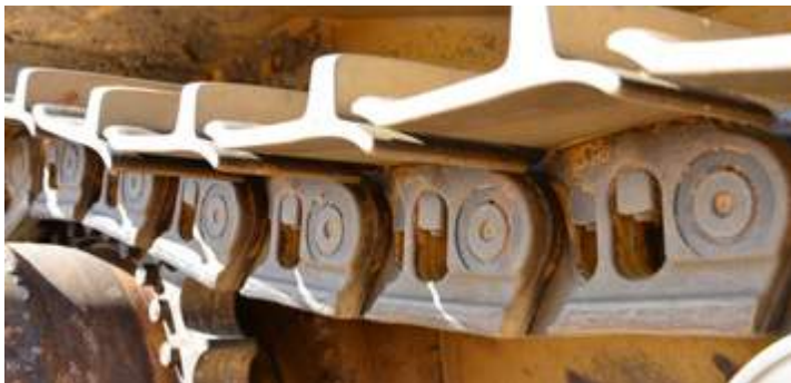
Detail of track chains during inspection at 1200 working hours. Détail des chaînes d’entraînement pendant l’inspection à 1200 heures de travail.
