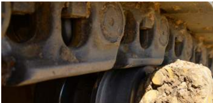
Detail of the track chains during inspection at 1300 working hours. Détail des chaînes d’entraînement pendant l’inspection à 1300 heures de travail.
