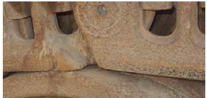
Detail of track chains during inspection at 2200 working hours. Détail des chaînes d’entraînement pendant l’inspection à 2200 heures de travail.
